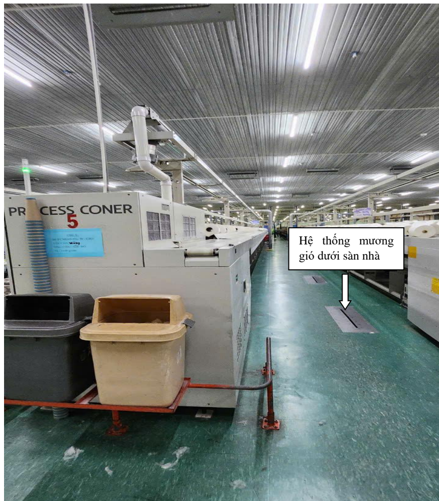
Hình 3.8. Hệ thống mương gió dưới sàn nhà
