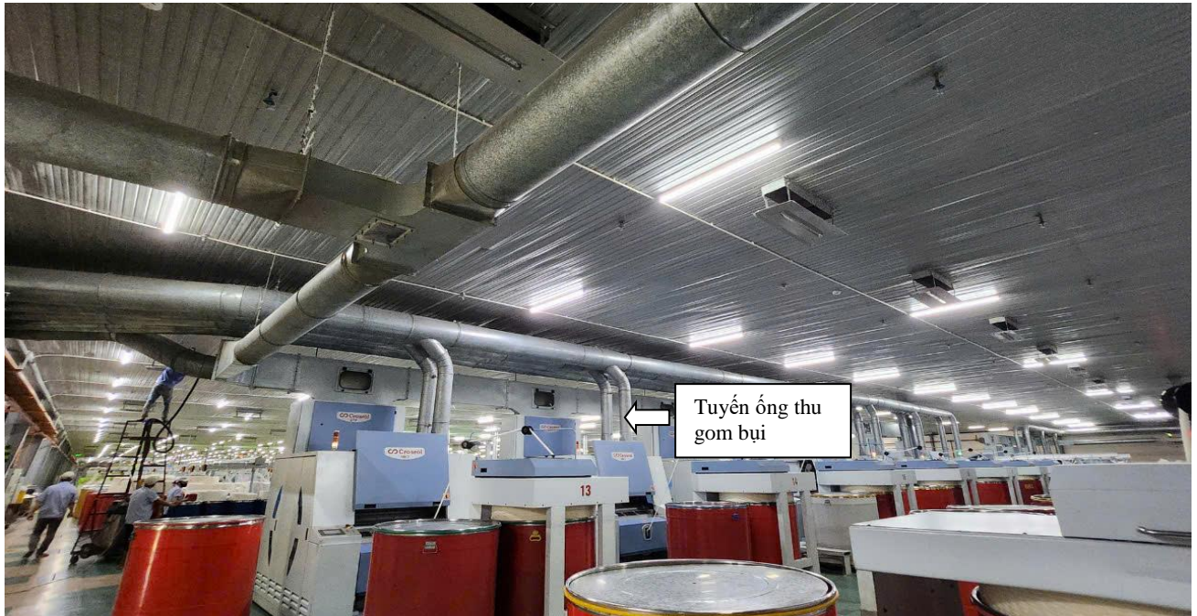
Hình 3.7. Tuyến ống hút bụi
