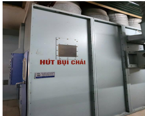
Hình 3.10. Máy hút bụi trung tâm
