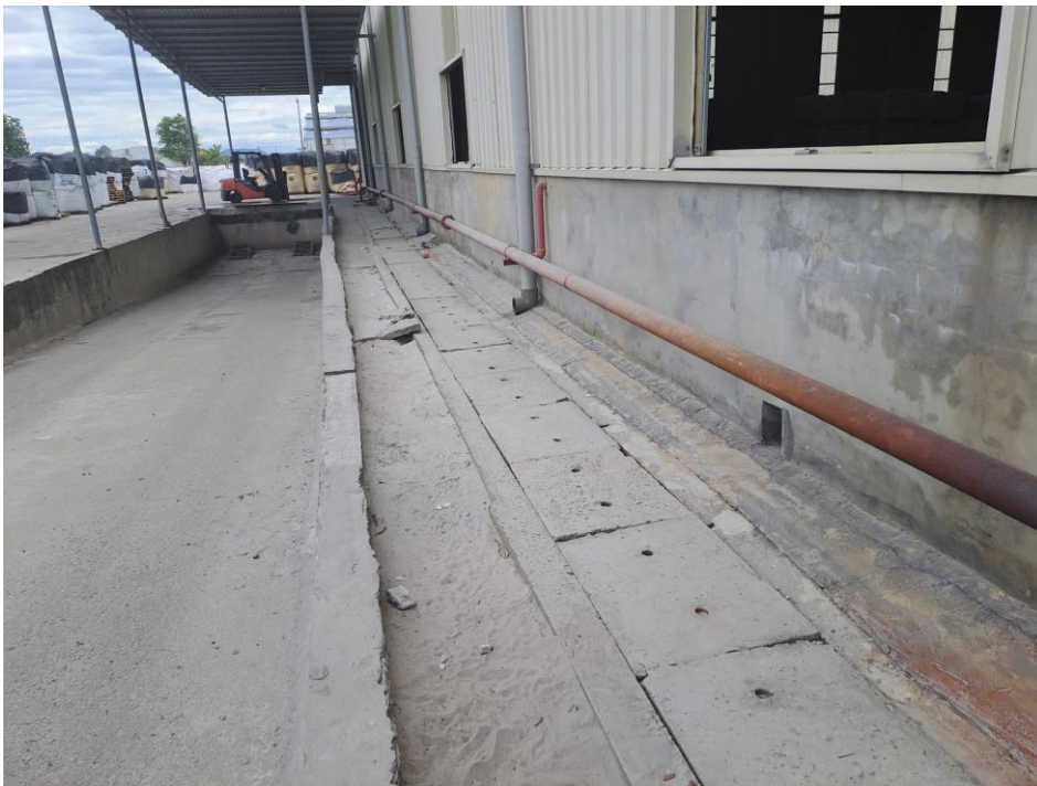
Hình 3.1. Hệ thống thu gom nước mưa
